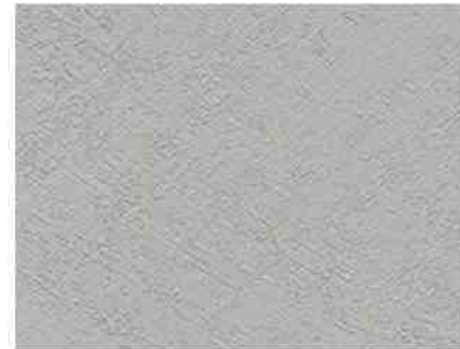
텍스처 콘크리트 TEXTURE CONCRETE
